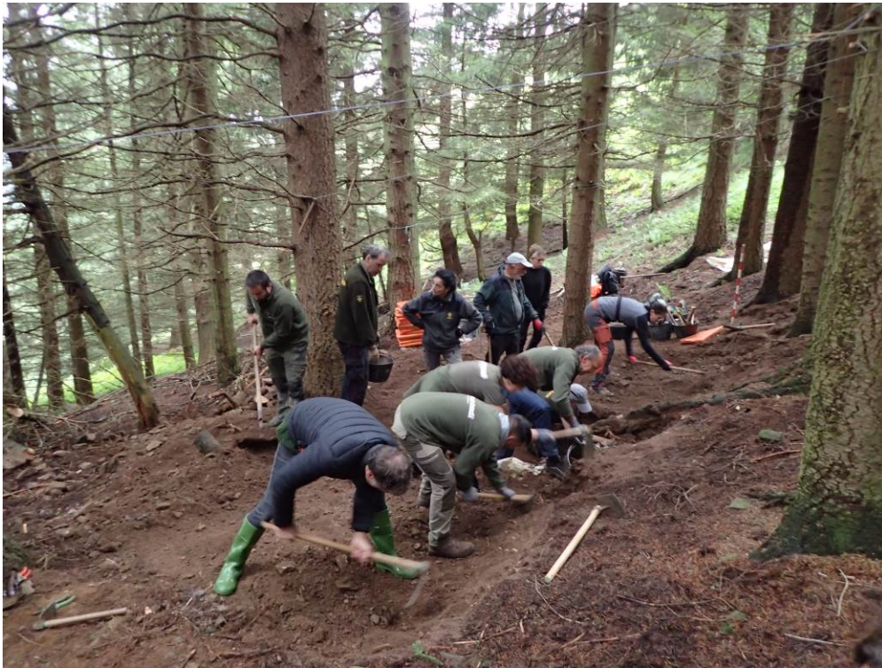
Figura 12. Labores iniciales de excavación.
